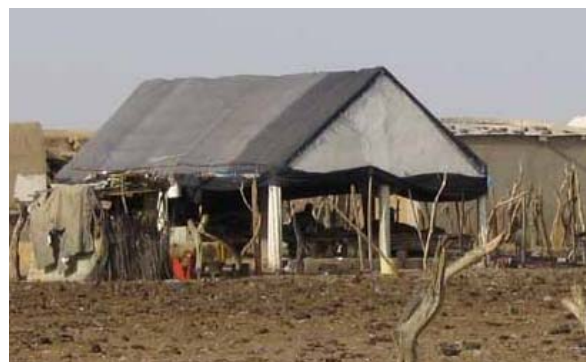
Photo 9 : Hangar maure en ciment (mars 2005)
