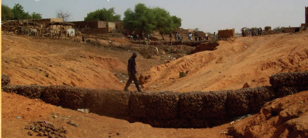
Seuil en gabions sur l'oued dispensaire
